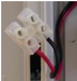
Рисунок 10. Клеммы для подключения замка к блоку питания
