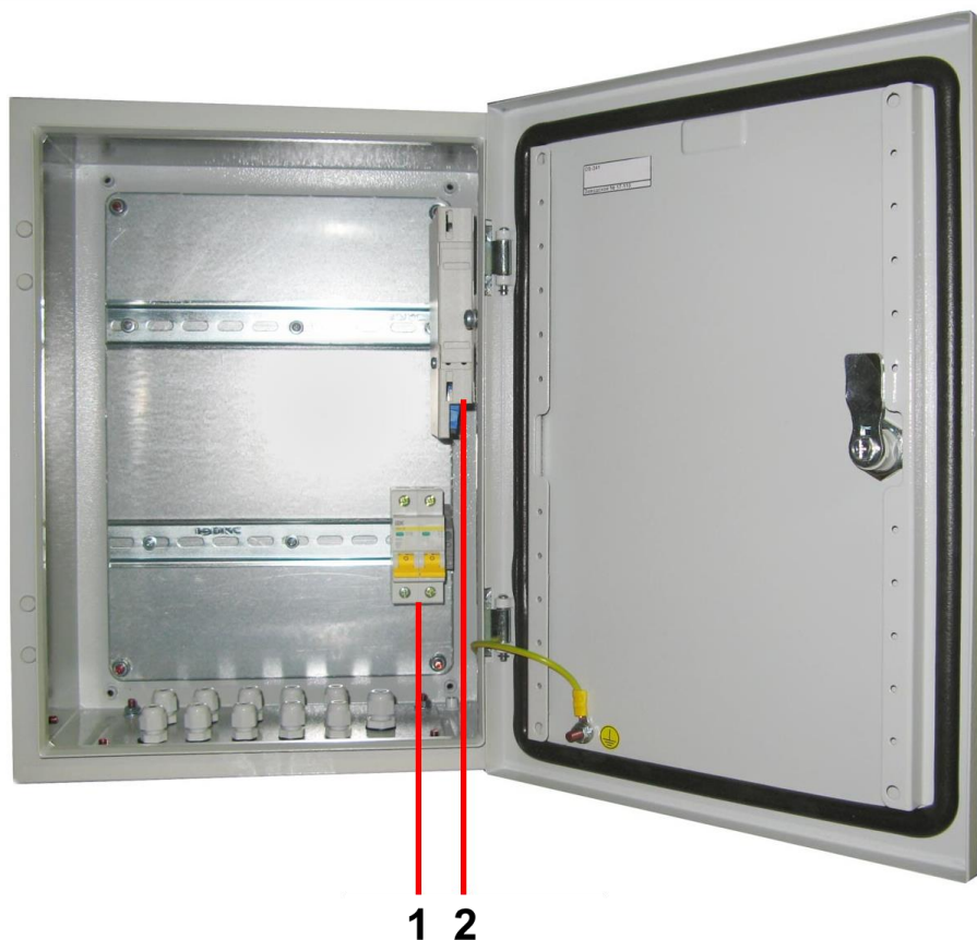
Рис.14 Базовая уличная станция OS-341, внутренние элементы
